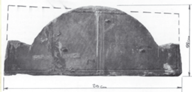
Keerzijde van hetzelfde tympaan. Duidelijk zichtbaar is dat een oude grafsteen gebruikt is. Foto Rijksmuseum Amsterdam.
