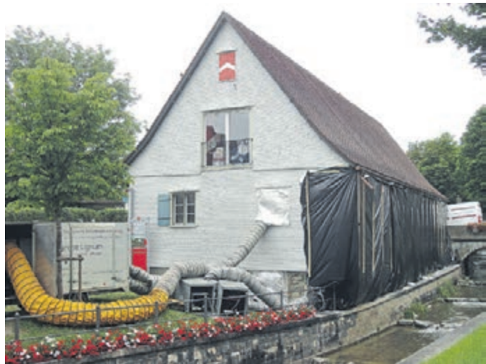
Das Kornhaus wurde im Juli über Luftkanäle thermisch gegen den Holzwurm behandelt.
