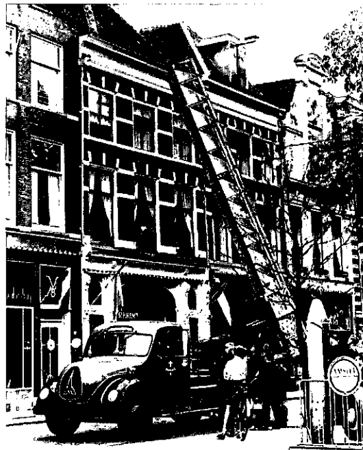
Hulpverlening met de brandladder. Hier wordt een gevelsteen verwijderd op de Melkmarkt, 1958.
