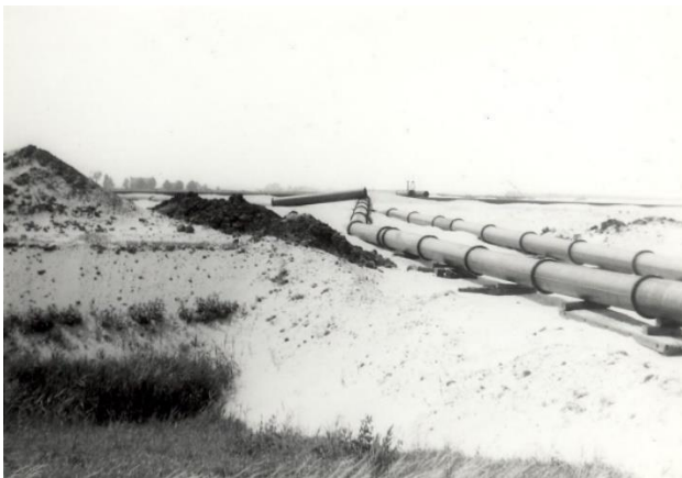
Figuur 5: Aanleg van pijpleidingen bij Ruigoord, juli 1970 52
